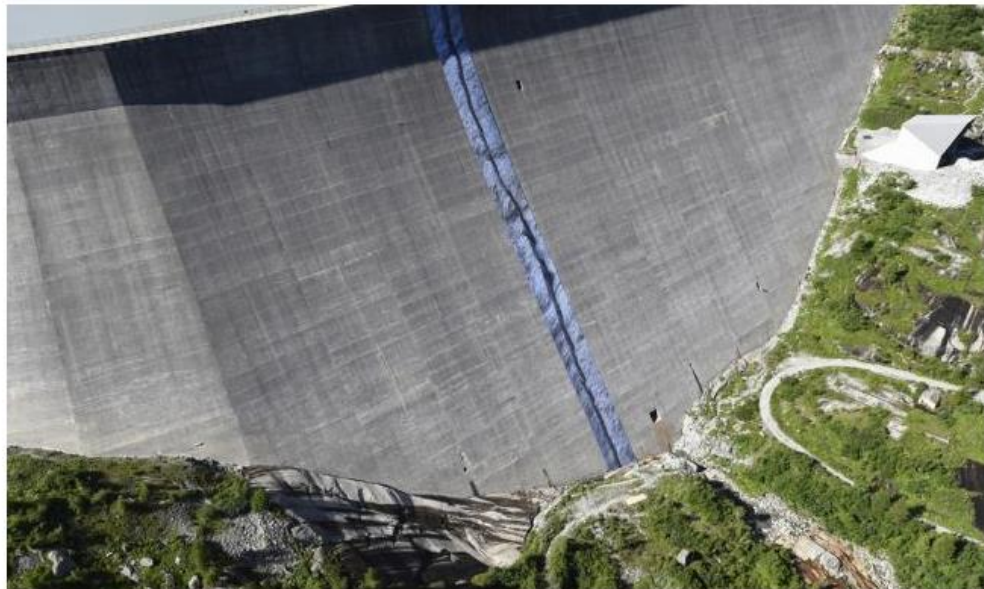
Stauseen: Leergepumpt um von den hohen Strompreisen zu profitieren. Keystone
